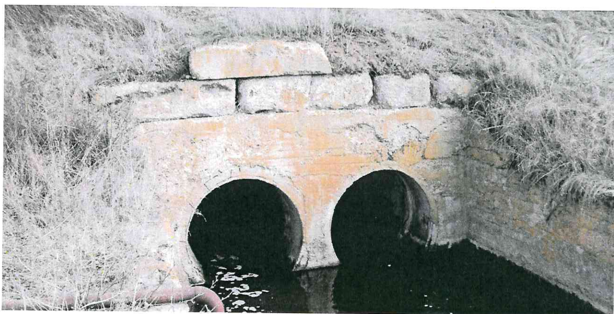
Фото 5 - Труба переезд на участке дороги от х. Мокрый Керчик до х. Николаевка
